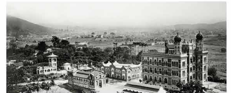
Núcleo arquitectónico original de Manguinhos, donde se concentraban, hasta la década de 1930, las principales actividades del instituto. Parte de este conjunto está catalogado por Patrimonio Federal desde 1981
